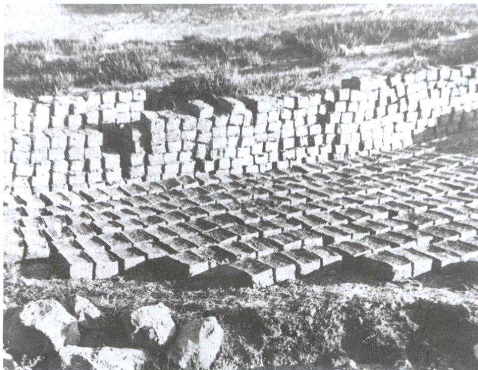
Fabricação de tijolos — Cortesia, Levant Photo Service
