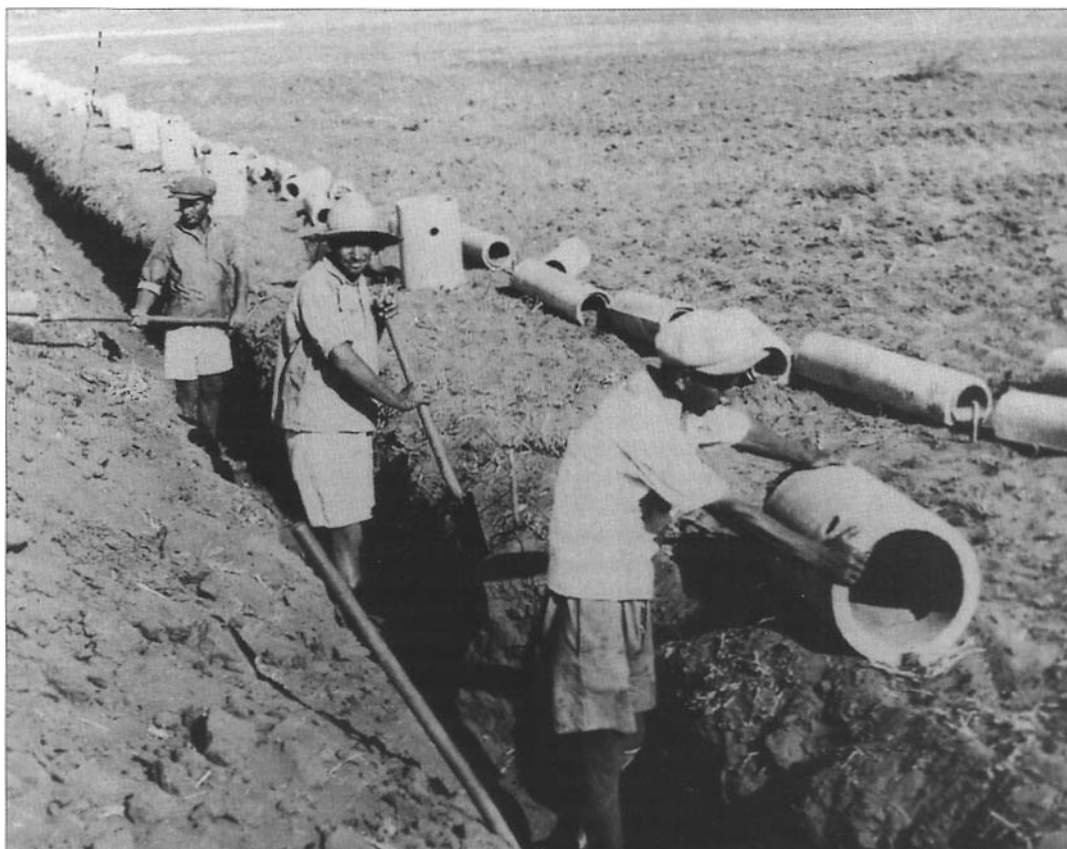
Colocando tuberías para el drenaje de pantanos en el valle Jéfer. Archivo fotográfico - KKL.
