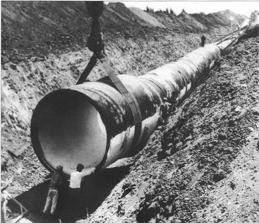
Colocación de las tuberías del Movil Ha-Maim Ha-ArtzÍ . Oficina de prensa israelí. Archivo fotográfico – KKL.
