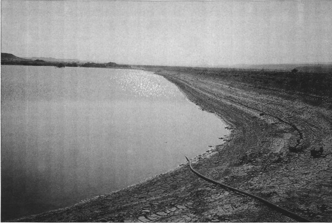
Represa de agua para riego construida por el Keren Kaiémet Leisrael en la zona desértica del Néguev, 1995. Archivo fotográfico - KKL.
